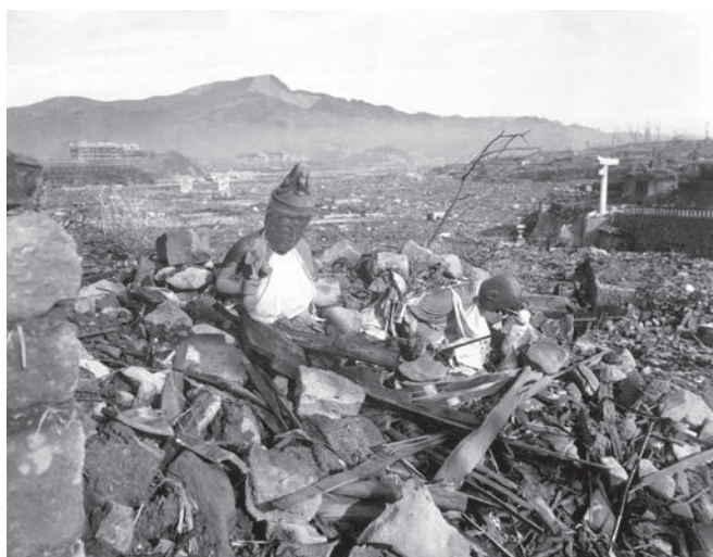
Et ødelagt tempel i Nagasaki
