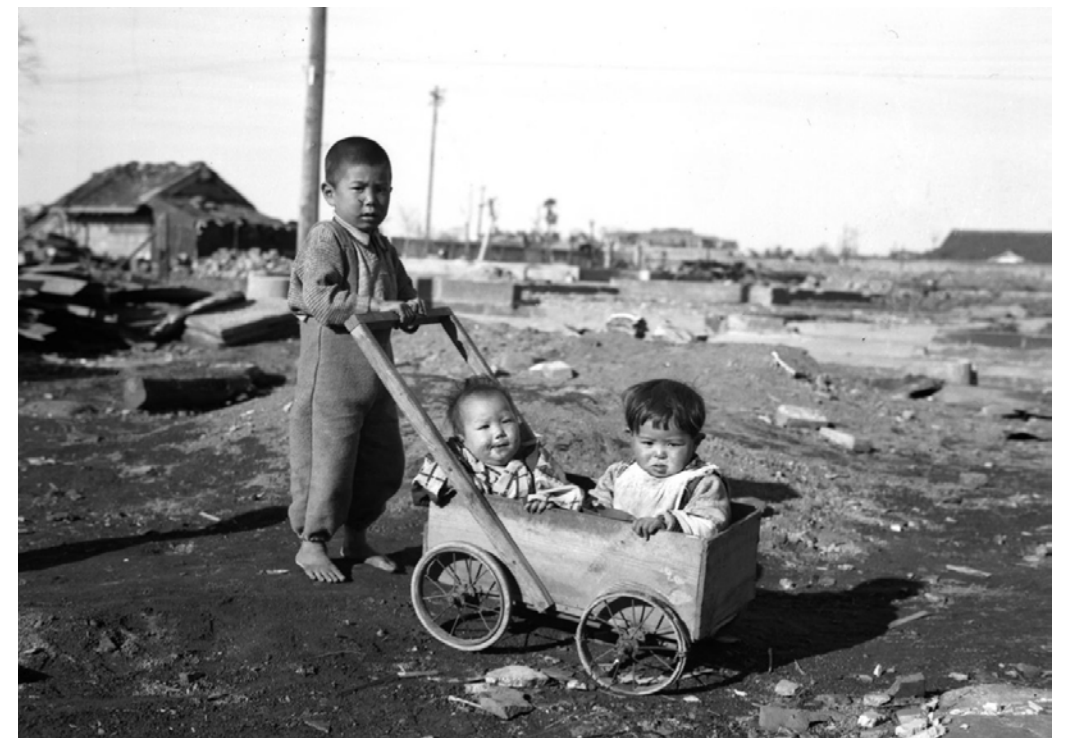
Barn beveger seg gjennom ruinene i Nagasaki én måned etter angrepet. Foto: Joe O'Donnell.
